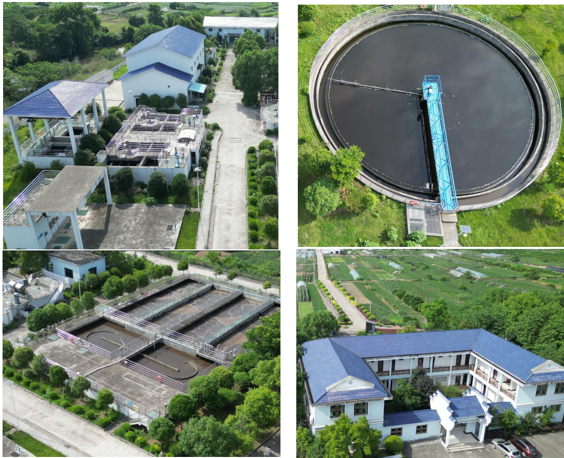
污水处理厂厂区现状
