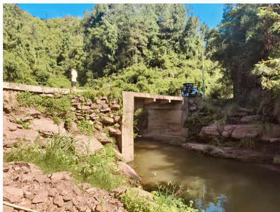
图 2.1.1-1 蛮潭溪现状图一
