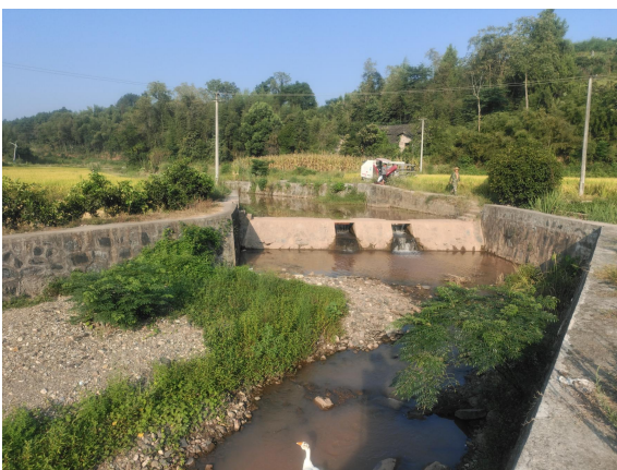
图 2.1.1-2 祖冲溪现状图二
